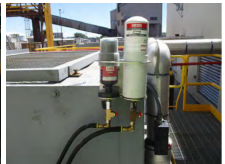
Fin fan lubrication
